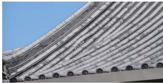
見つかった本堂屋根瓦のむくれ
