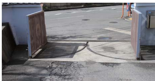
ひび割れの目立つ南西門スロープ部分
