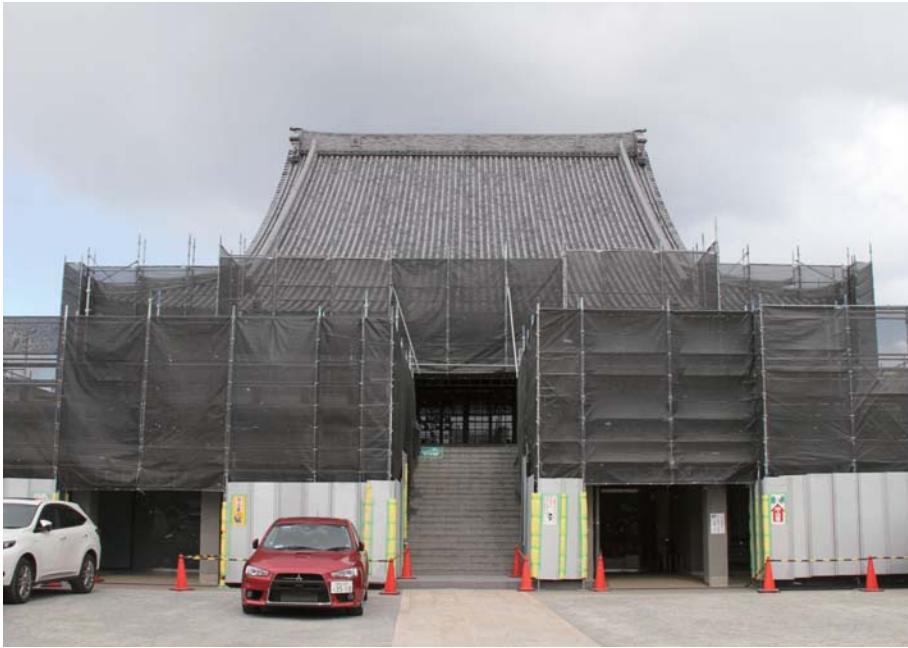
改修工事中の鷺森別院(3月10日撮影)
