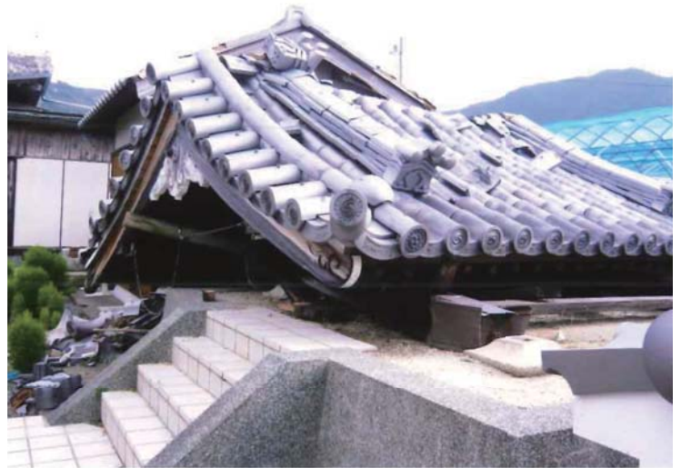
倒壊した鐘楼(有田北組光源寺)
