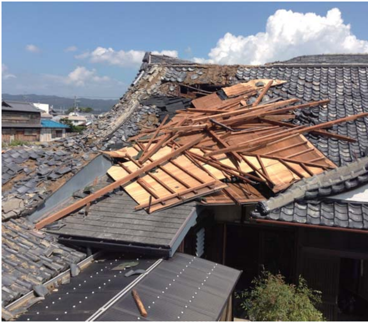
強風で飛んできた建物の屋根が庫裏を覆う(海草組真宗寺)
