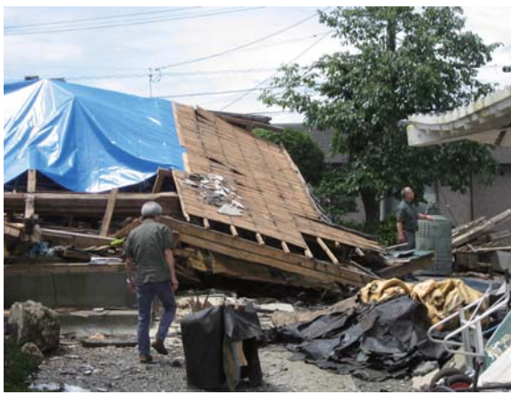
倒壊した庫裏の撤去作業が続く専寿寺
