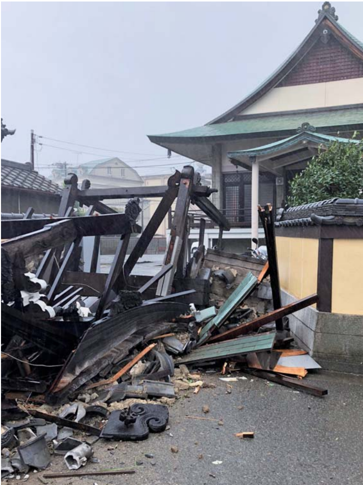
強風で倒壊した山門(和歌山組西教寺)
