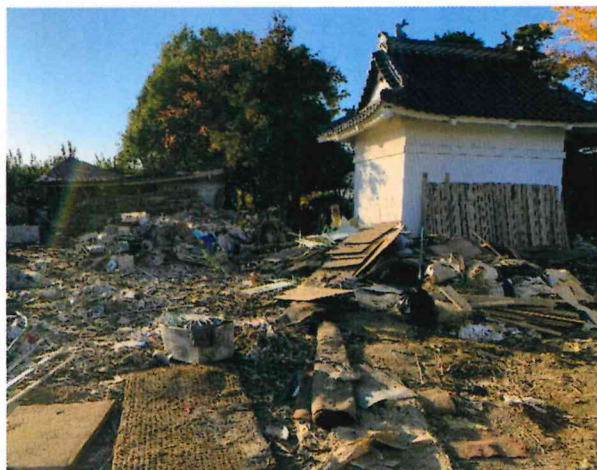
千曲川の堤防決壊で浸水被害を受けた真宗大谷派正覚寺(長野市津野八幡)
