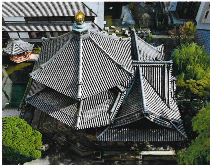
隣接するビル「WEST 18」から六角堂を一望。六角宝形造りの本堂に参拝のための前殿をつなげた形がよく分かる
